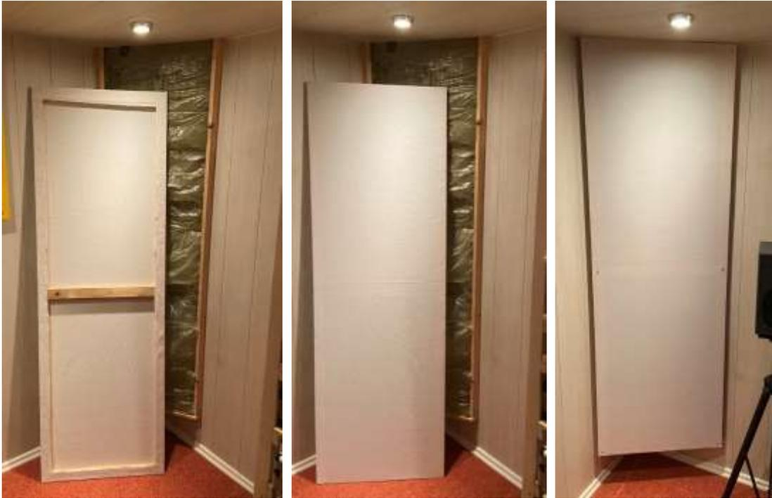
Die Abdeckung auf den Eckabsorber halten und mit 6 Schrauben auf den seitlich der Absorptionskeile angebrachten Dachlatten befestigen. Tipp: den genauen Abstand der beiden Platten ausmessen und mit dieser Distanz im Abdeckrahmen vorbohren. Ich empfehle diesen Schritt zu zweit auszuführen oder vorher gut zu frühstücken 😊
