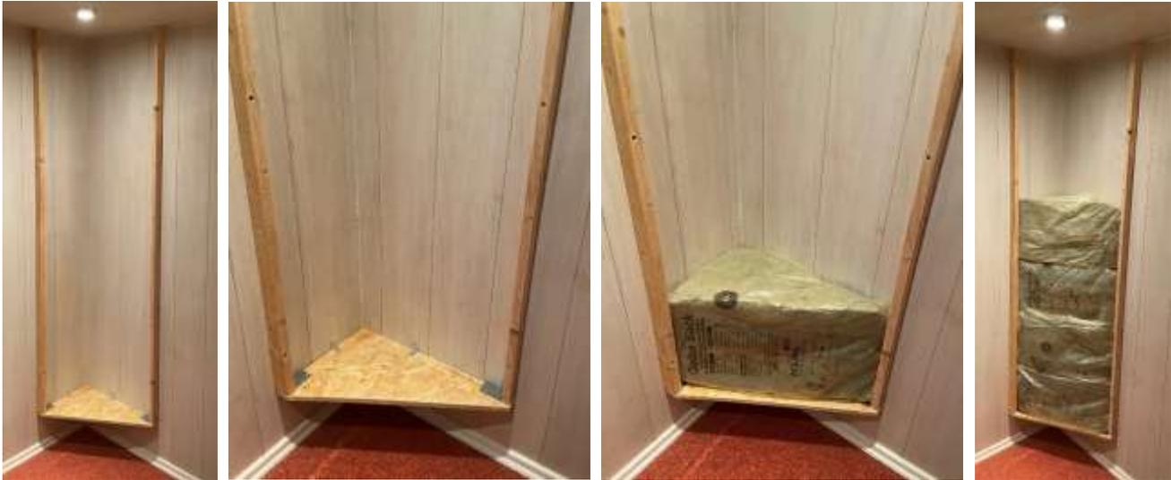
Zuerst die OSB Platte diagonal teilen und die Spitzen kappen. Dann die beiden Dachlatten im Abstand von 35 und 50 cm zur Ecke an die Wand schrauben. Die Winkel unten anbringen und mit der dreieckigen Platte verschrauben. Zur Stabilisierung noch zwei kleine Winkel zusätzlich an die Wand anbringen. Die Absorber-Keile bis zur Decke ein stapeln. Die Pakete komprimieren und noch eines mehr darauf packen, damit es hält.
