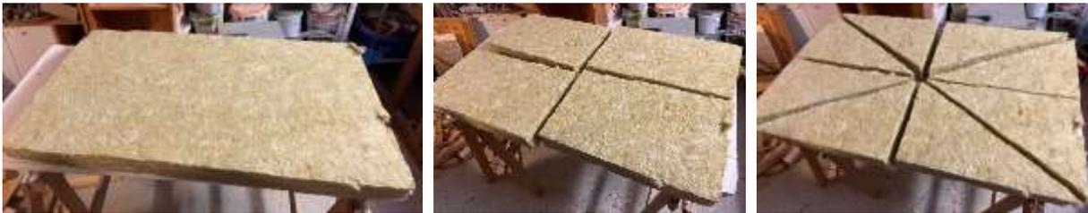
Achtung: Maske und Handschuhe tragen! Die Keile müssen möglichst genau, mit einem großen Brotmesser und einer Latte zugeschnitten werden, damit diese alle möglichst gleich groß werden.
